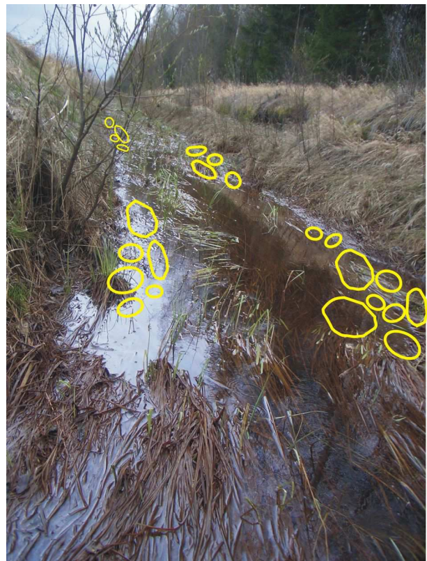
Kuva 53. Uoman luonnontilaa voi parantaa esimerkiksi rakentamalla tulvasanteita (vasemmanpuoleinen kuva) tai lisäämällä liettyneen uoman mutkittelua kiveämällä (oikeanpuoleinen kuva). Kuvat: Heli Harjula
